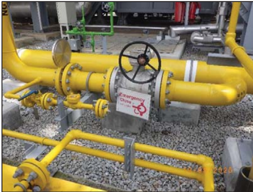
รูปที่ 2-30 อุปกรณ์วาล์วตัดแยกระบบ (Manual Isolation Valve)
