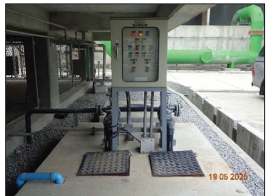
รูปที่ 2-6 ป่อแยกน้ำ-น้ำมัน (Oil Water Separator)
